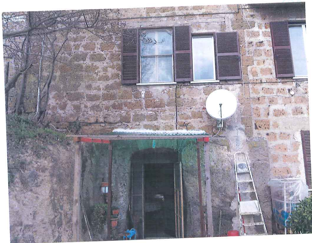
Fig.2 – Vista dell'ingresso all'appartamentino piano seminterrato Fg. 35 Part. 292 sub 4
