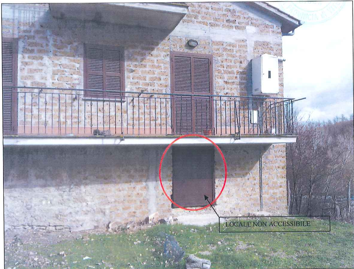
Fig.1 – Vista dell'ingresso al locale piano terra Fg. 35 Part. 435 sub 1
